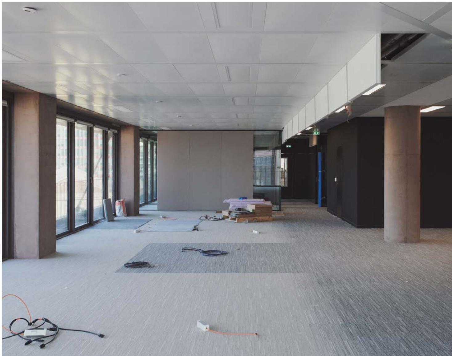
DIVERS TRAVAUX DE FINITIONS ARCHITECTURALES Boulogne D5, Mars 2026 ©Nicoloso Simon
