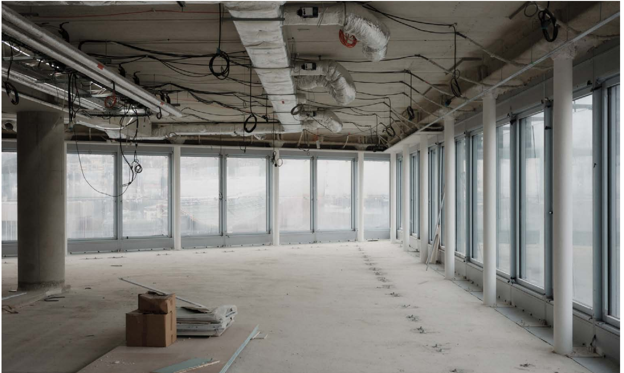
TRAVAUX INTÉRIEURS Boulogne D5, Janvier 2026 ©Nicoloso Simon
