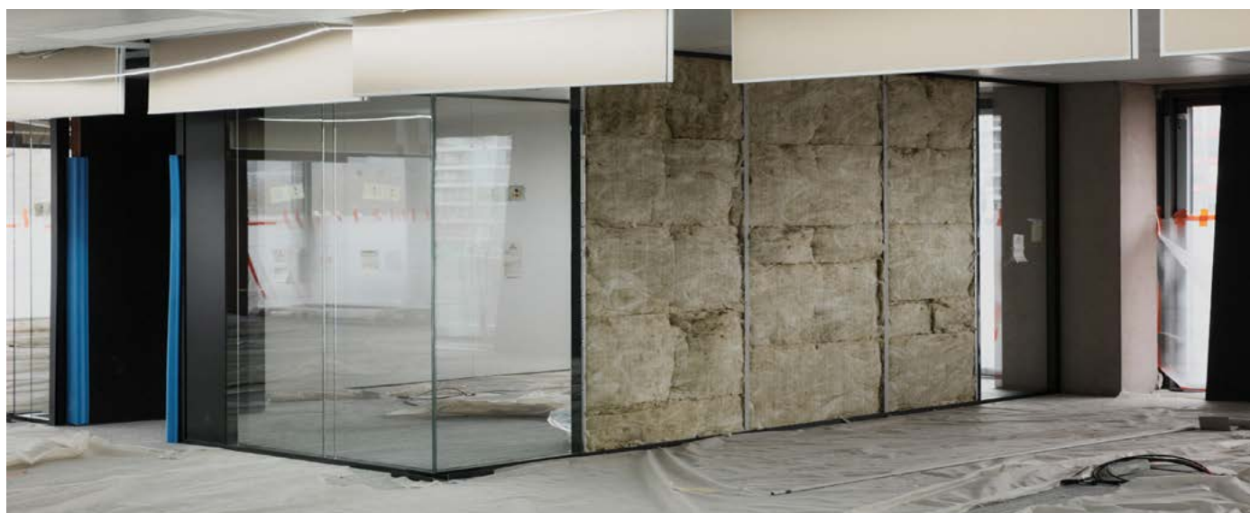
POSE DES CLOISONS AMOVIBLES Boulogne D5, Janvier 2026 ©Nicoloso Simon
