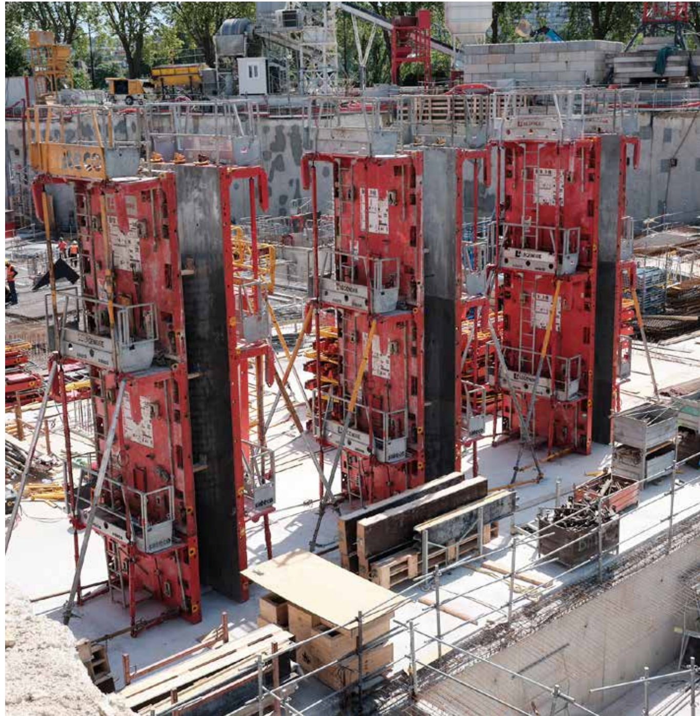
FONDATIONS / GROS OEUVRE Boulogne D5, Mai 2024 ©Nicoloso Simon
