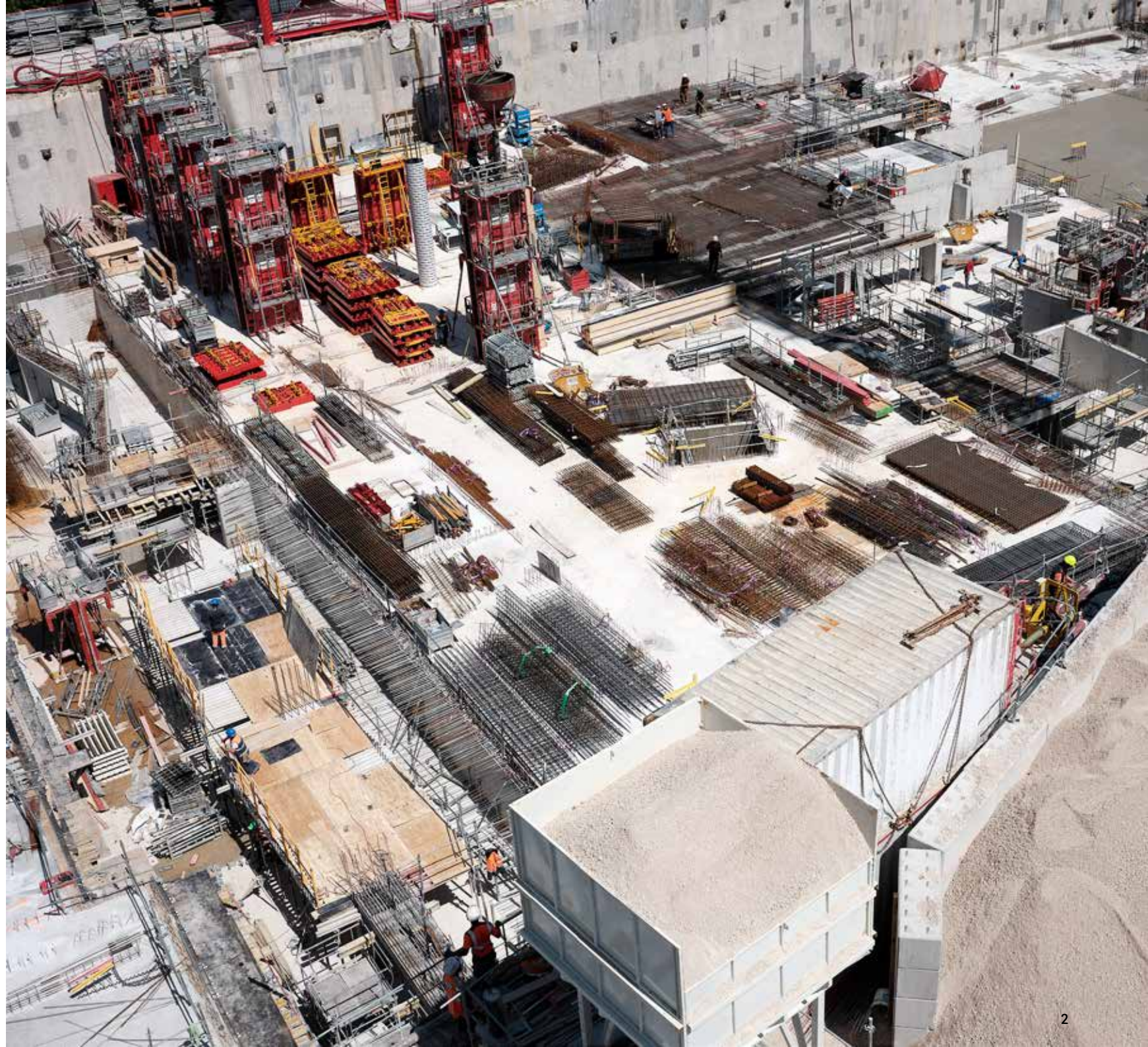
FONDATIONS / GROS OEUVRE Boulogne D5, Mai 2024 ©Nicoloso Simon
