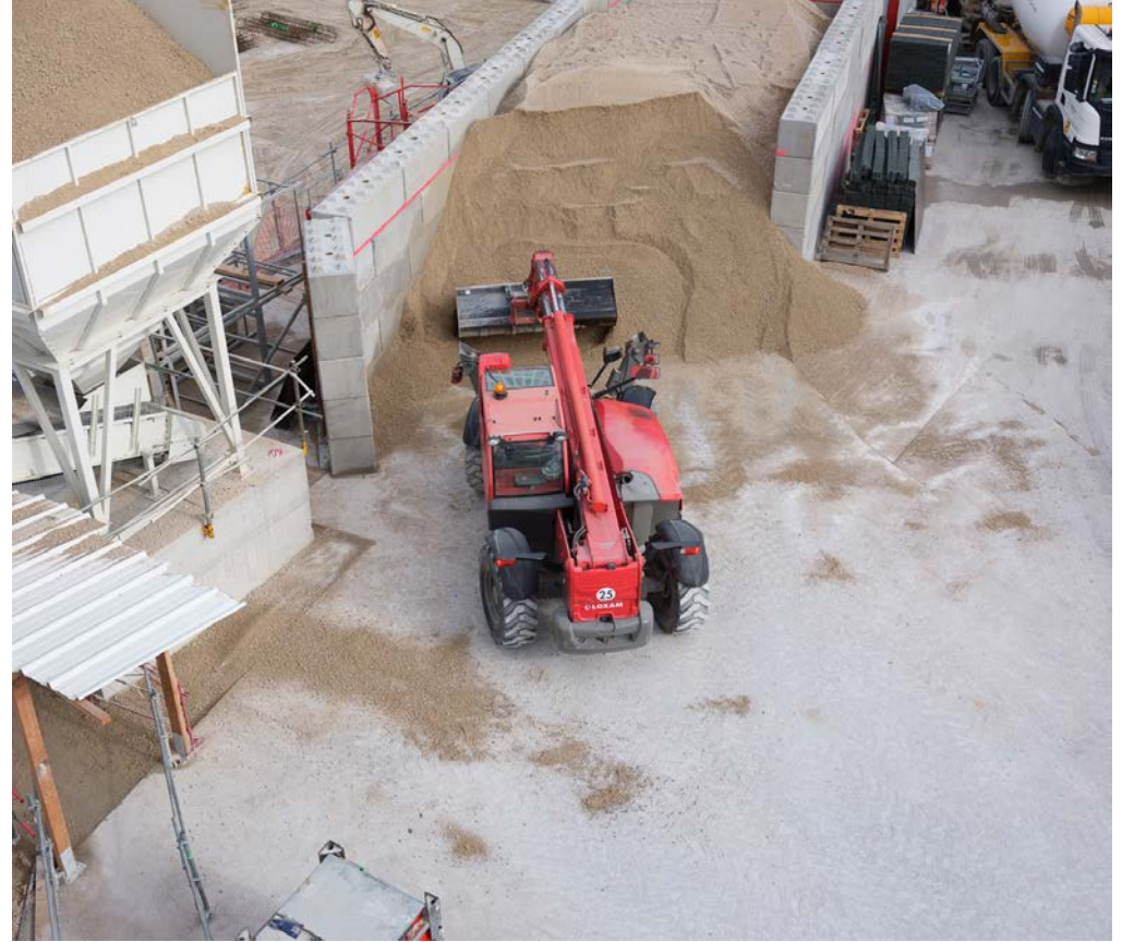
FONDATIONS / GROS OEUVRE Boulogne D5, Février 2024 ©Nicoloso Simon
