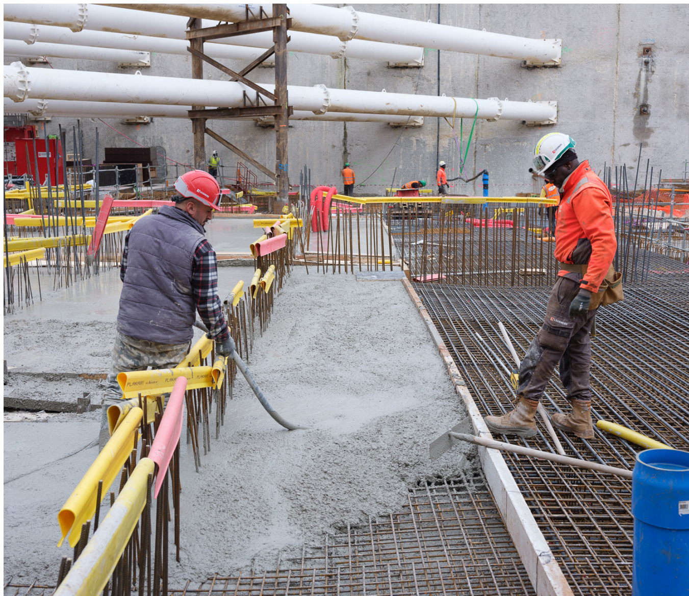
FONDATEMENTS / GROS OEUVRE Boulogne D5, Février 2024 ©Nicoloso Simon
