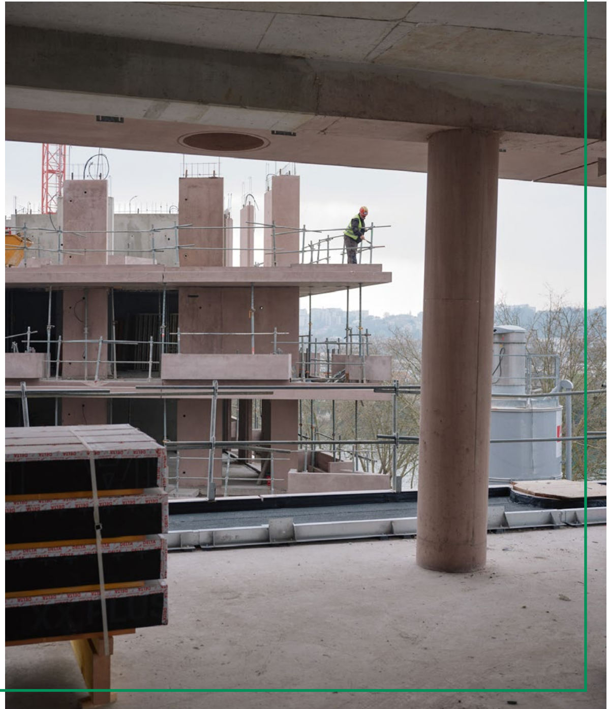
SUPERSTRUCTURE / GROS OEUVRE Boulogne D5, Mars 2025 ©Nicoloso Simon
